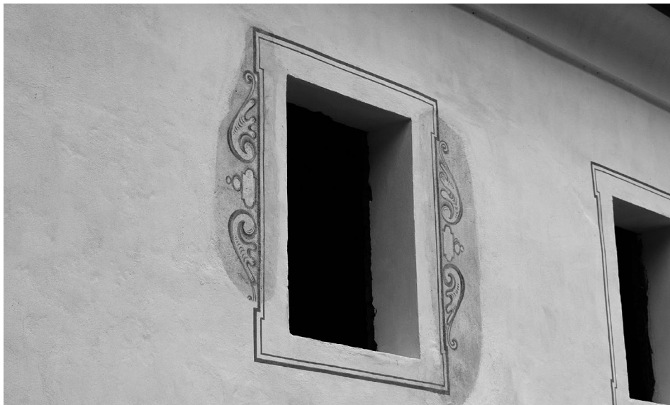
Slika 17: Okrasje okrog okna na vzhodni steni, severno od stopnišča in jaška za dvigalo (foto: Simona Kostanjšek Brglez)
