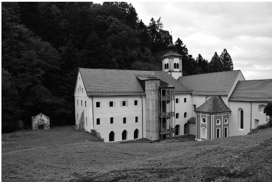
Slika 23: Zahodni trakt po obnovi (foto Simona Kostanjšek Brglez)
