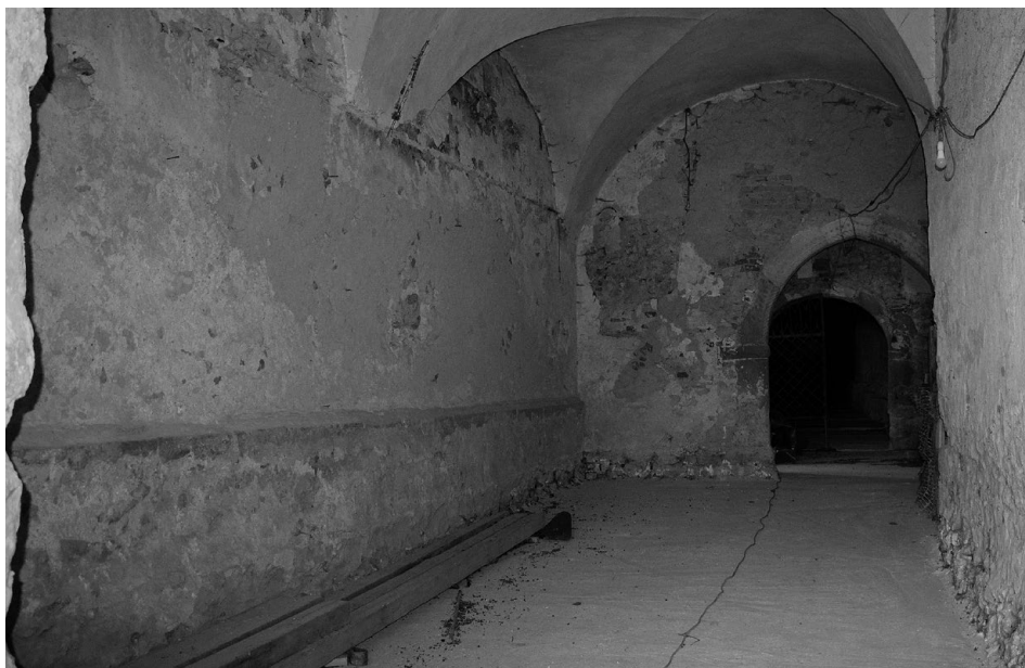
Slika 4: Zahodna stena ladje s talnim zidcem in pritličje nunske empore (foto: Simona Kostanjšek Brglez)
