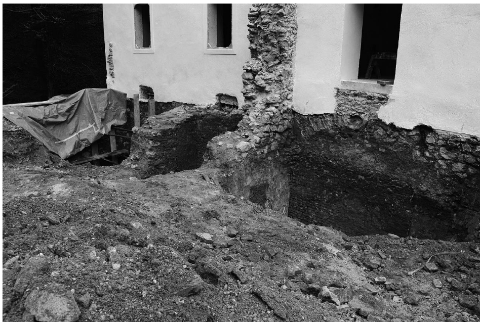
Slika 19: Izkopi na območju južnega dela zahodnega trakta (foto: Simona Kostanjšek Brglez)
