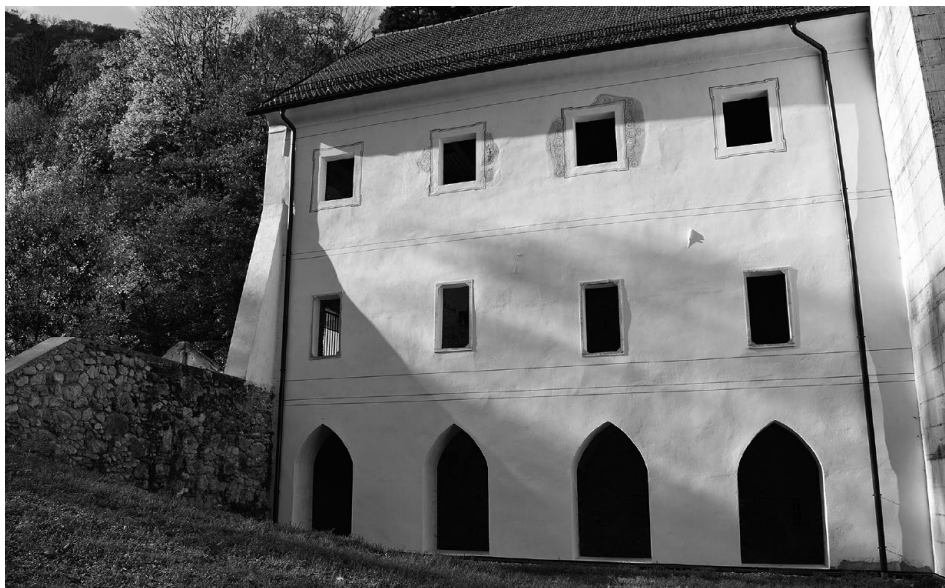
Slika 18: Vzhodna stena zahodnega trakta po obnovi (foto: Simona Kostanjšek Brglez)
