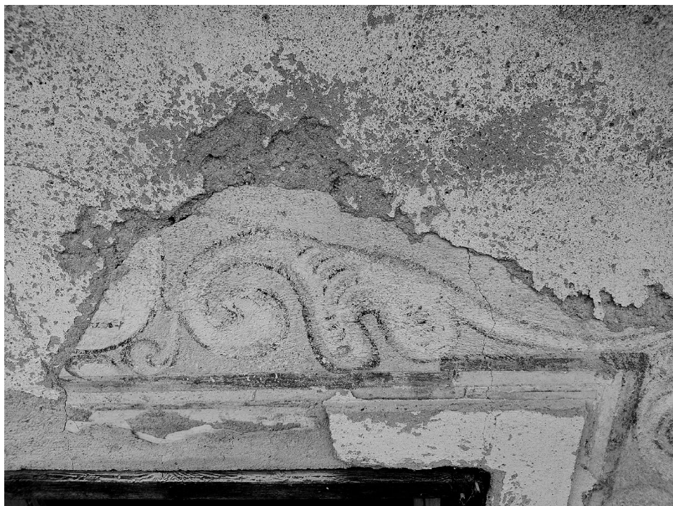
Slika 16: Okrasje okrog okna na vzhodni steni, južno od stopnišča in jaška za dvigalo (foto: Simona Kostanjšek Brglez)
