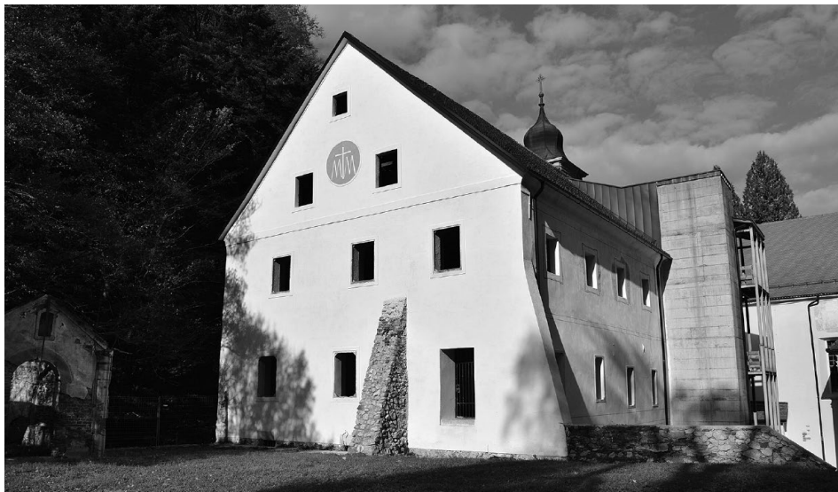
Slika 15: Južna fasada zahodnega trakta po obnovi (foto: Simona Kostanjšek Brglez)
