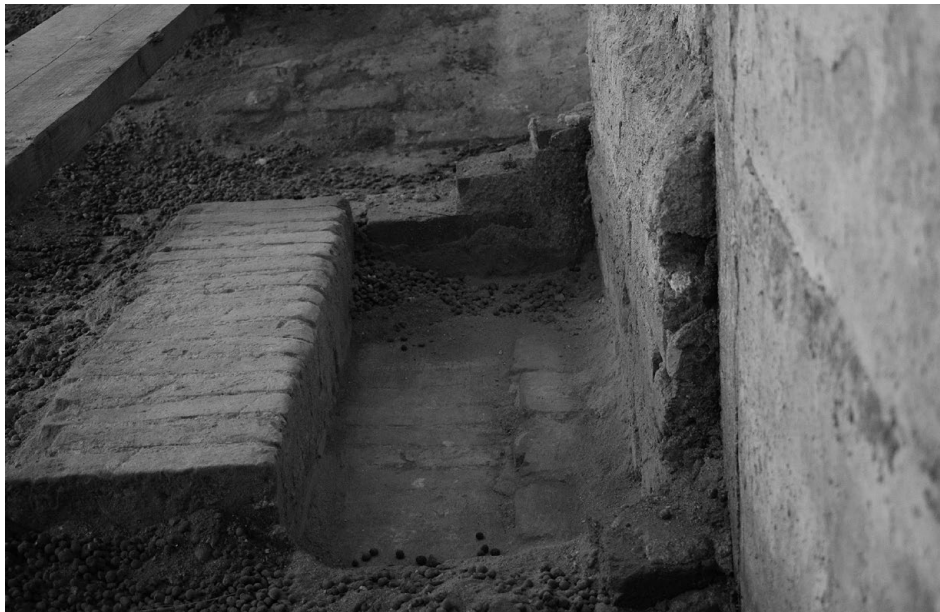
Slika 9: Opečne stopnice, ki so vodile v dvorano (foto: Simona Kostanjšek Brglez)
